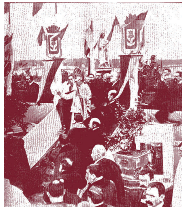
COLOCACION DE UNA PRIMERA PIEDRA BORGOS. SOLEMNE ACTO DE COLOCACION DE LA PRIMERA PIEDRA DE LAS CASAS PARA OBREROS POR INICIATIVA DEL CIRCULO CATOLICO DE BORGOS
