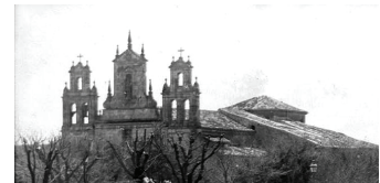
BURGOS: Polémica en torno al derribo de la iglesia del Carmen
