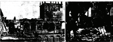
Convento destruido por un incendio
