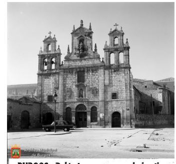
BURGOS: Polémica en torno al derribo de la iglesia del Carmen El templo —con más de tres siglos de existencia— será demolido para levantar una iglesia modernista.
