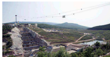
Mueren 4 trabajadores al aplastarles una cubeta de hormigón en Burgos
